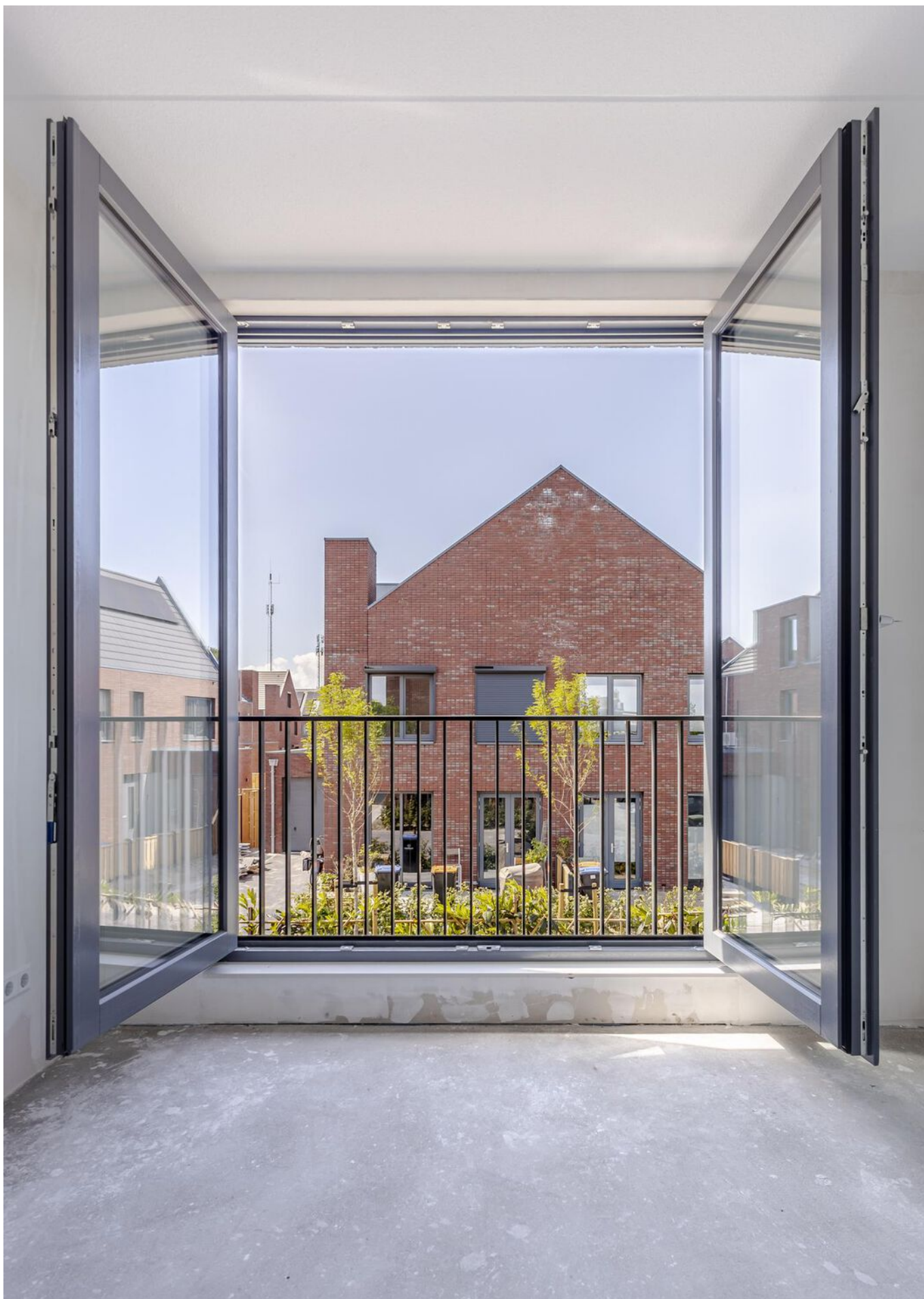
Frans balkon op 1e verdieping aan de voorzijde
