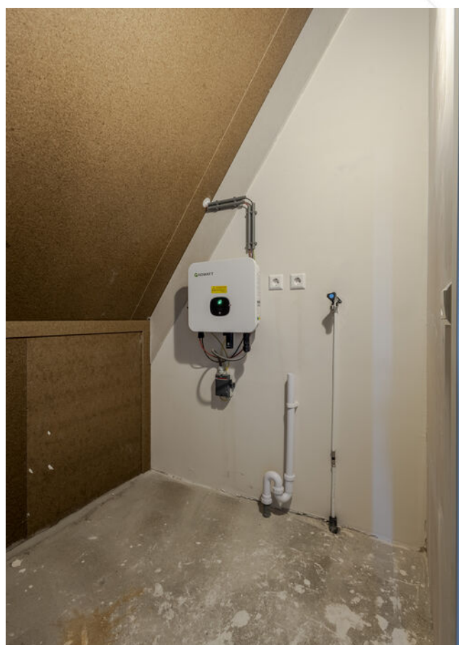
Omvormer zonnepanelen
