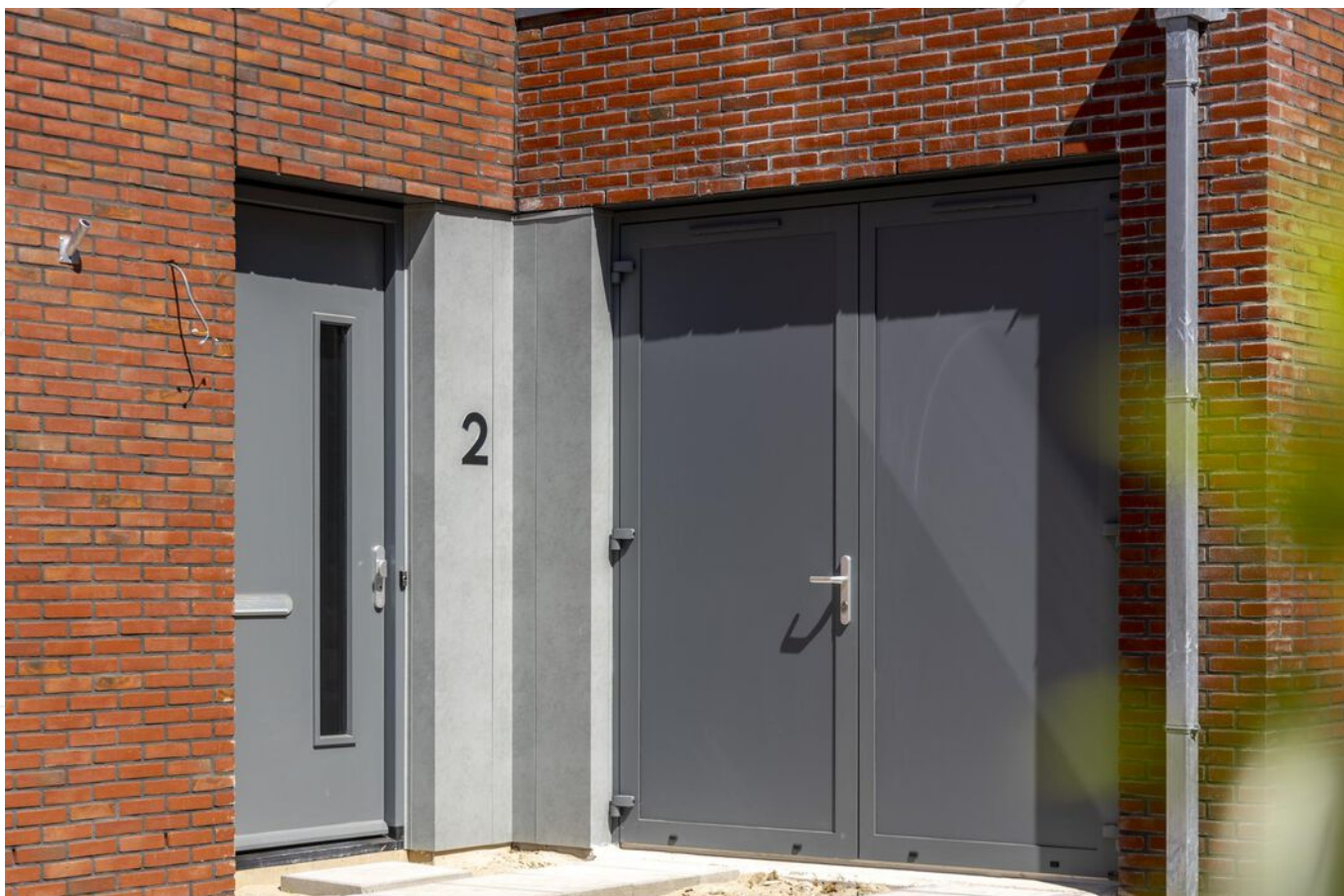
Entree deur en garagedeur
