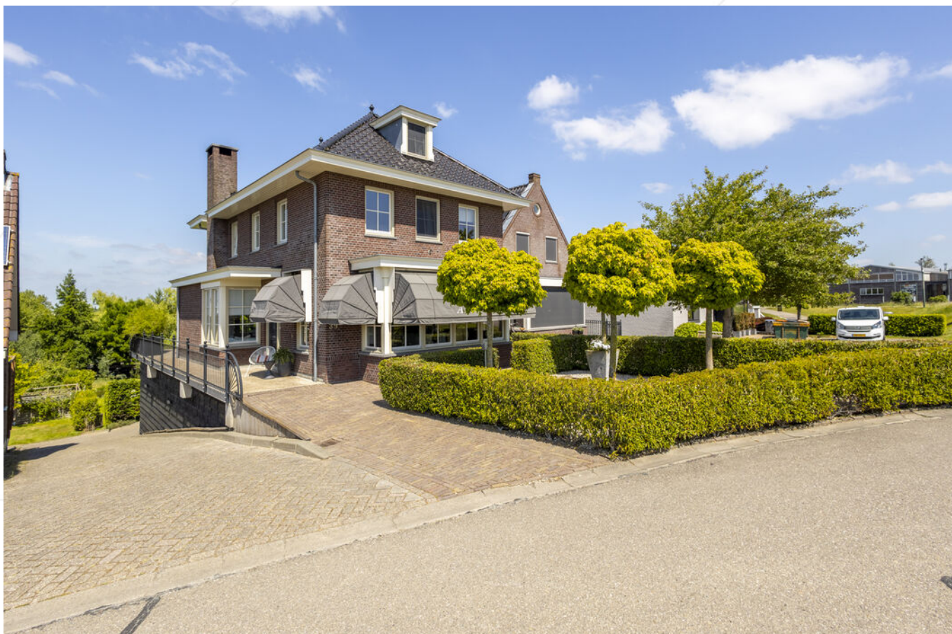
Overzicht woning met afrit
