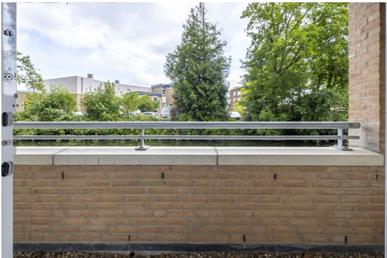
Loggia ( bereikbaar vanuit slaapkamer 1)
