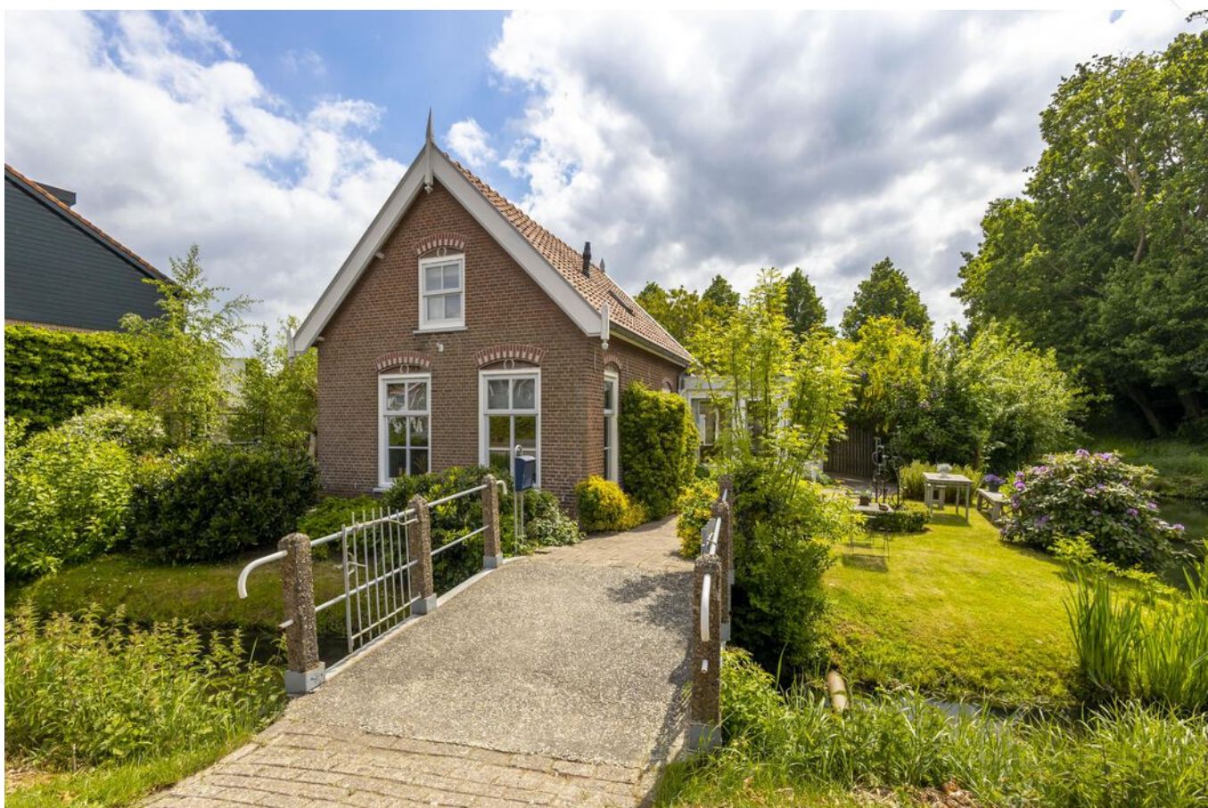
Toegangsbrug naar woning
