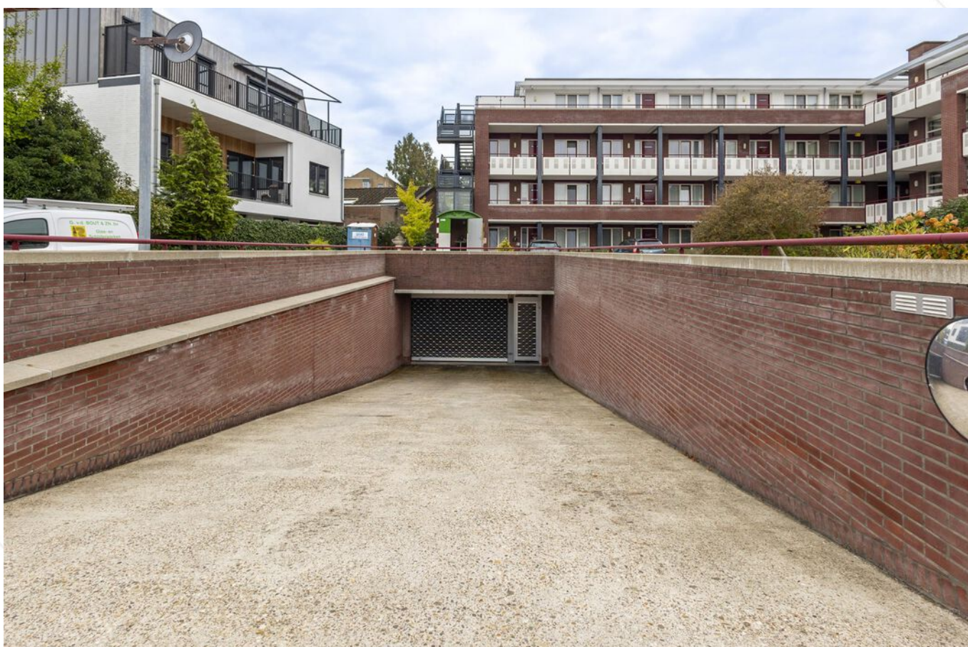
PEntree naar parkeergarage
