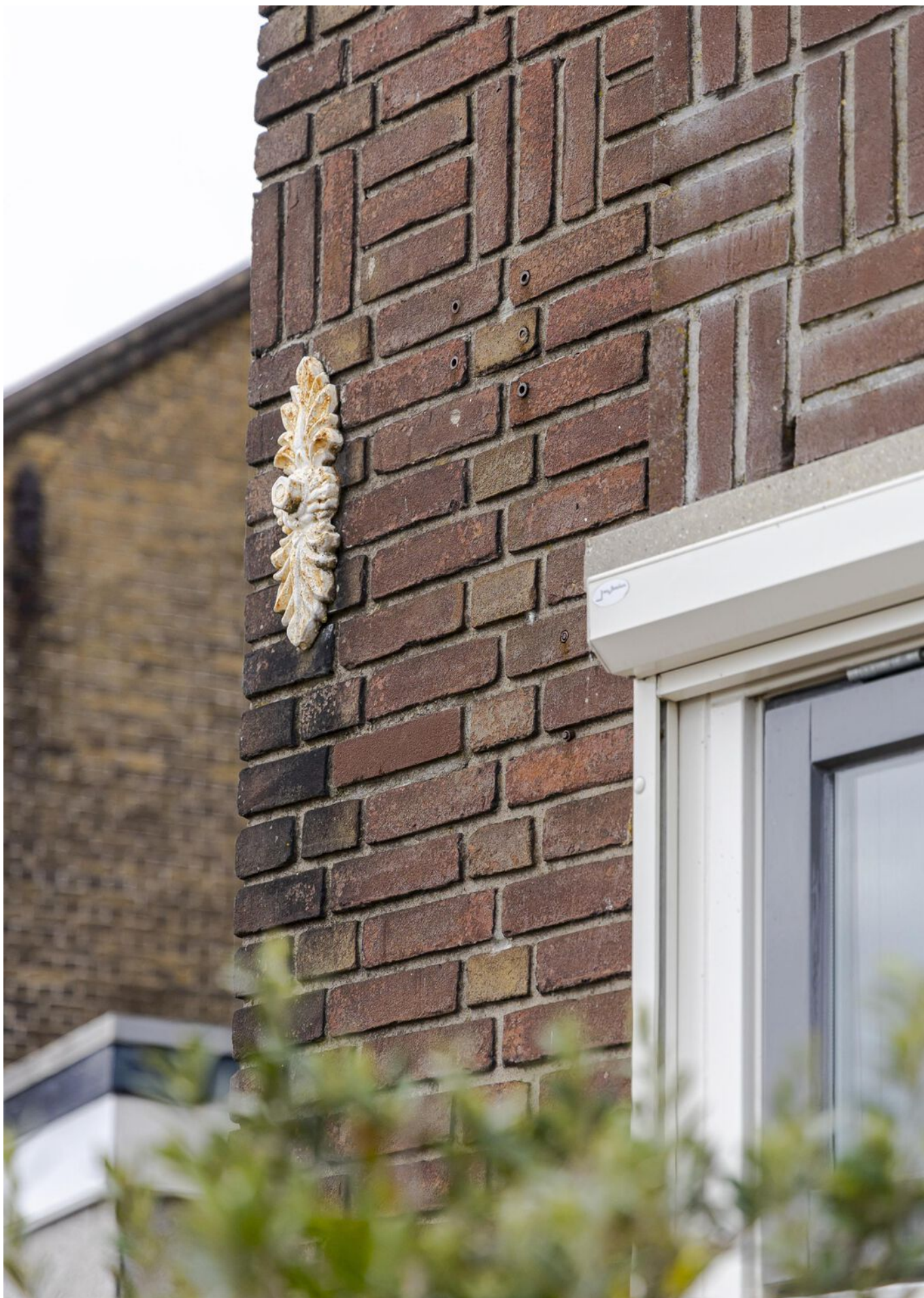
Detail metselwerk en sierafsluiting
