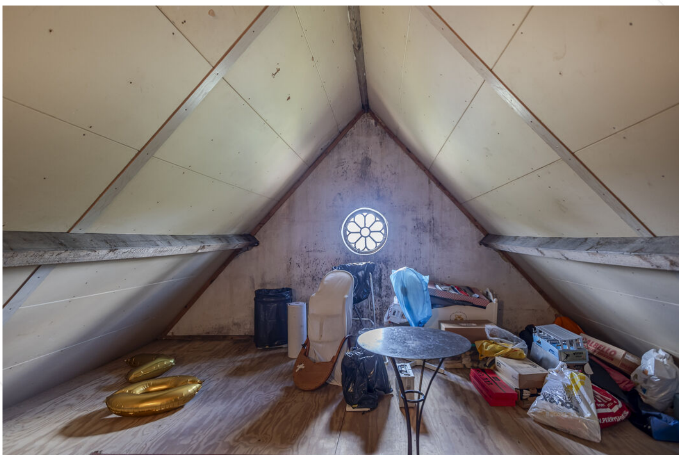
Zolder - huidige situatie
