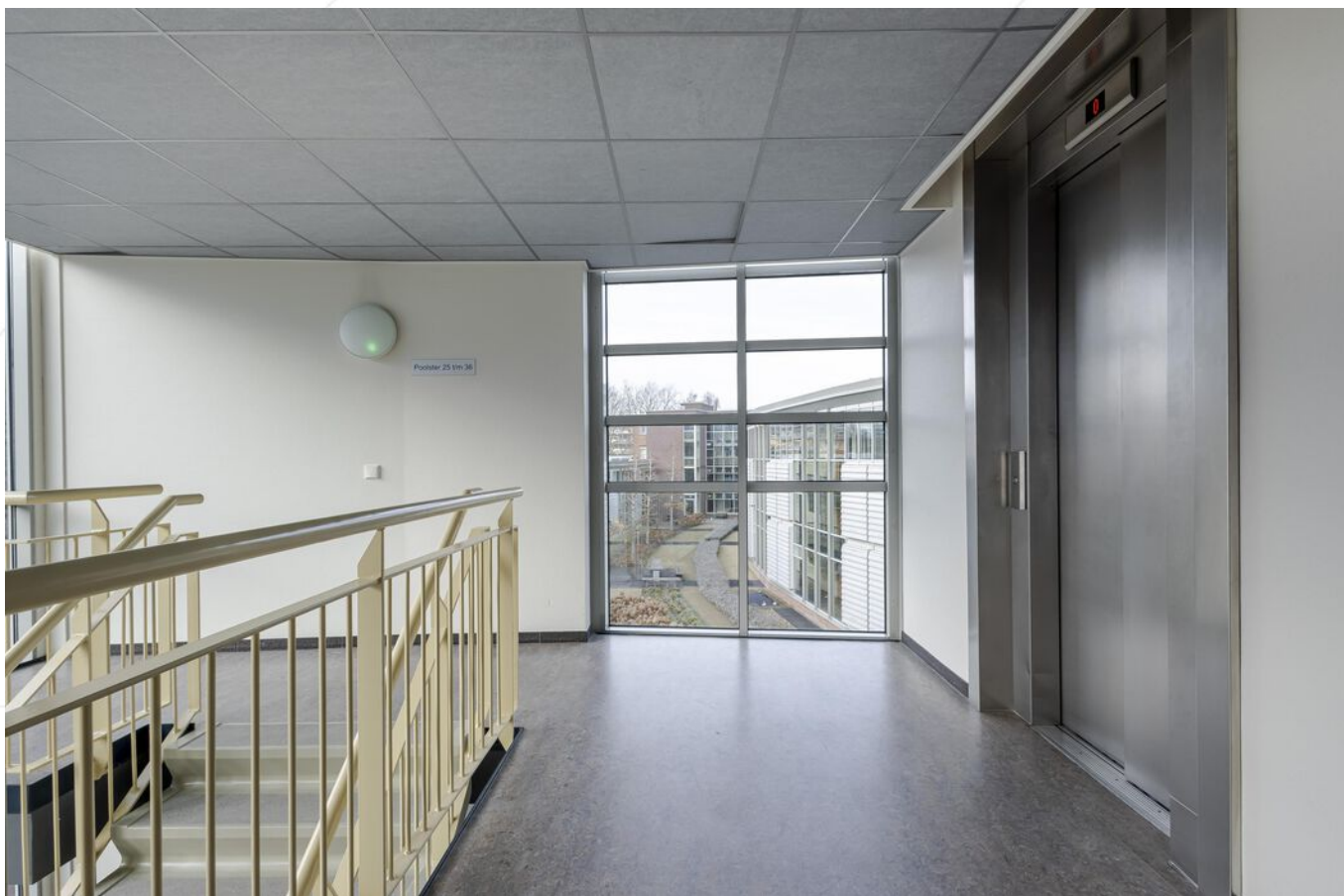
Centrale hal appartementengebouw met liftinstallatie en trappenhuis
