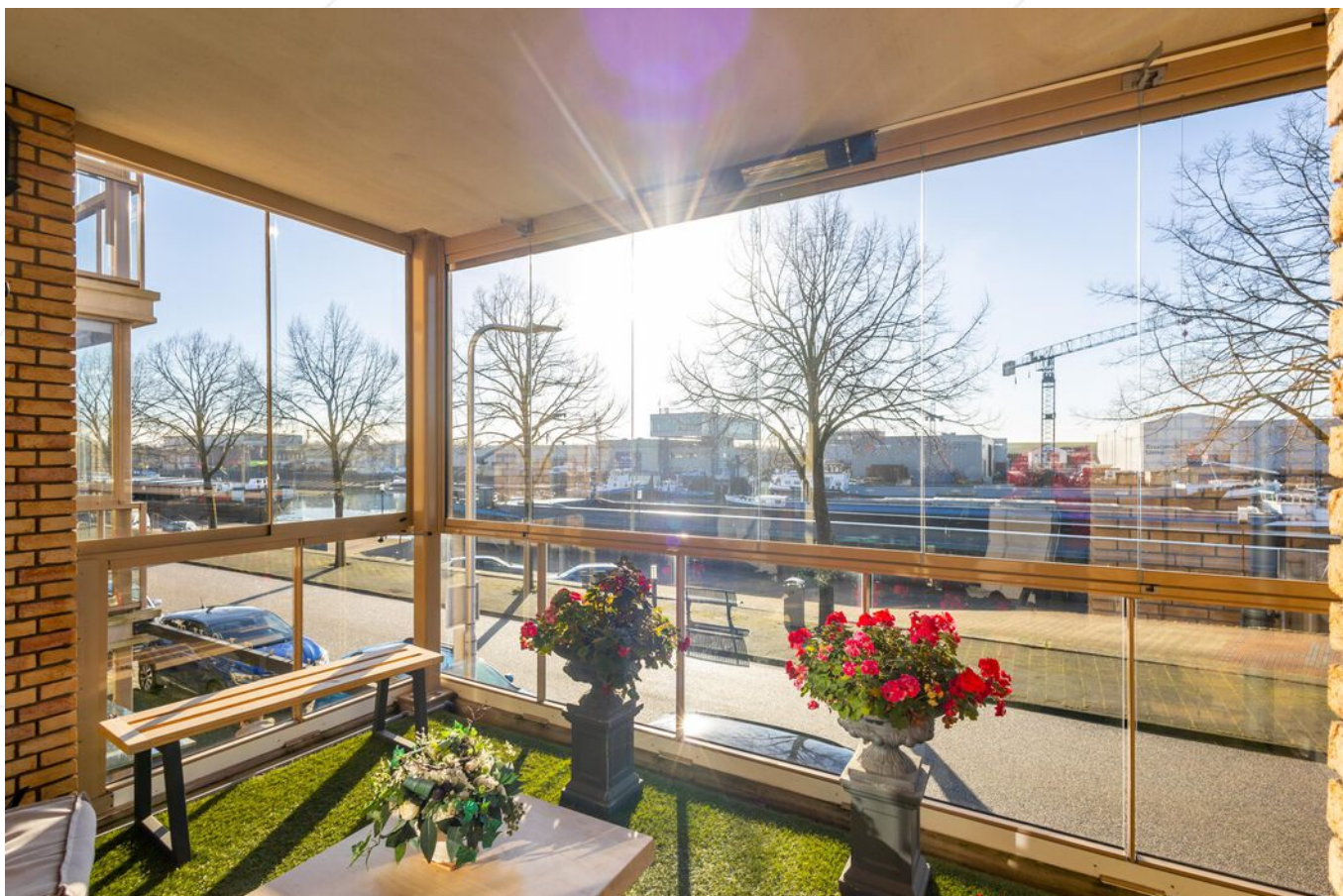
Balkon met wegschuifbare beglazing (bovenzijde)
