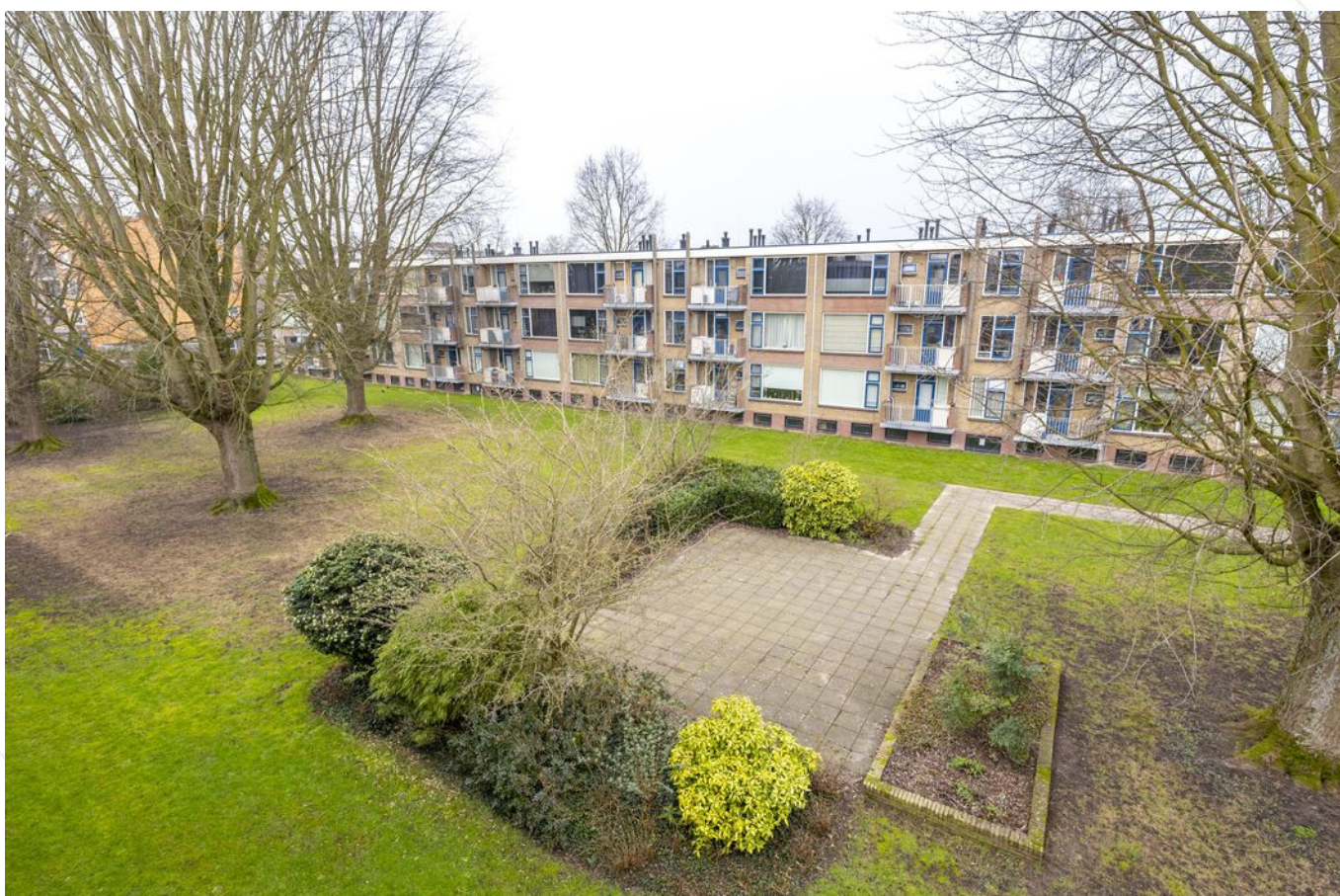
Uitzicht vanaf het balkon aan de achterzijde
