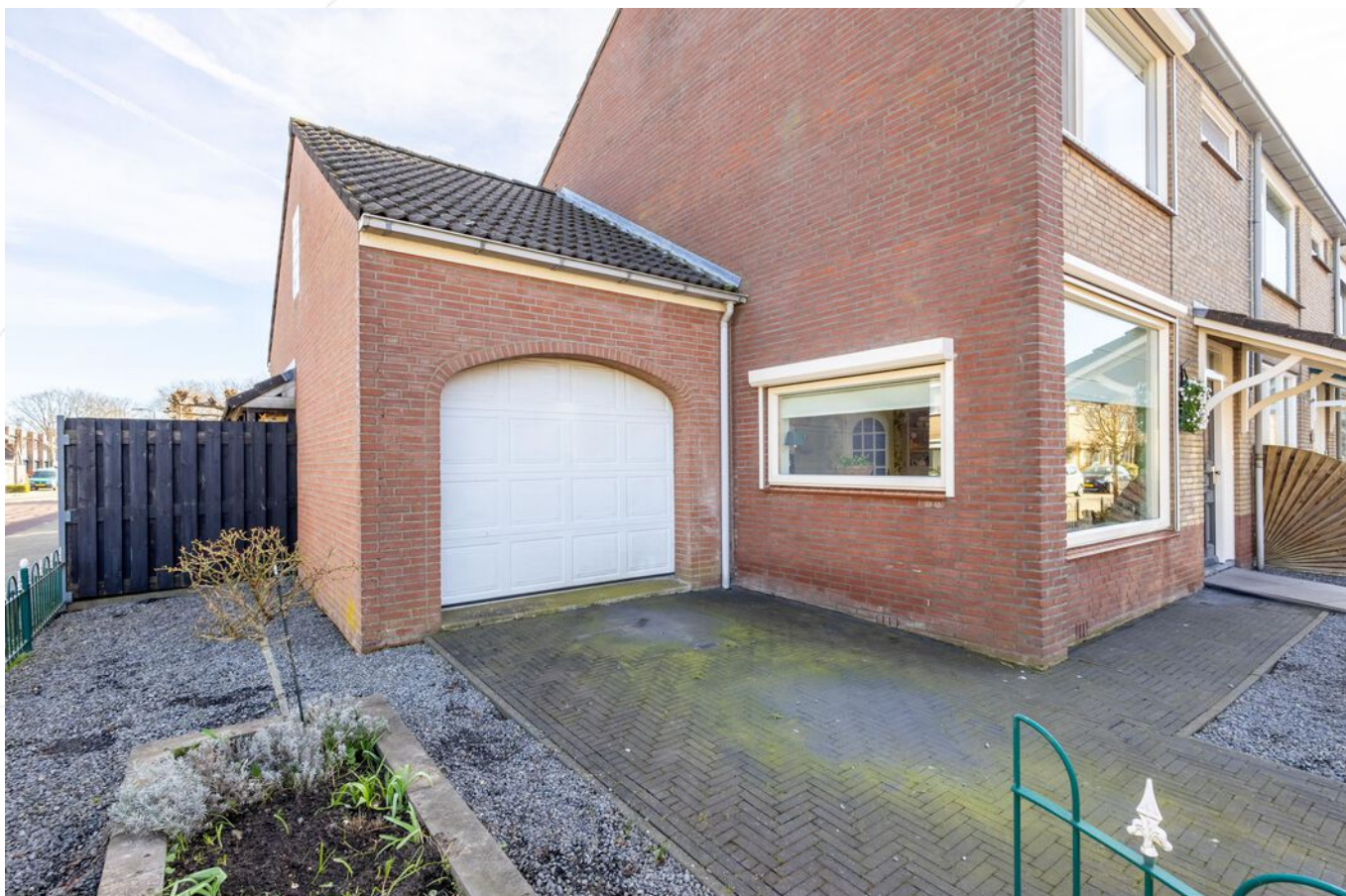
Voorzijde woning met aangebouwde garage
