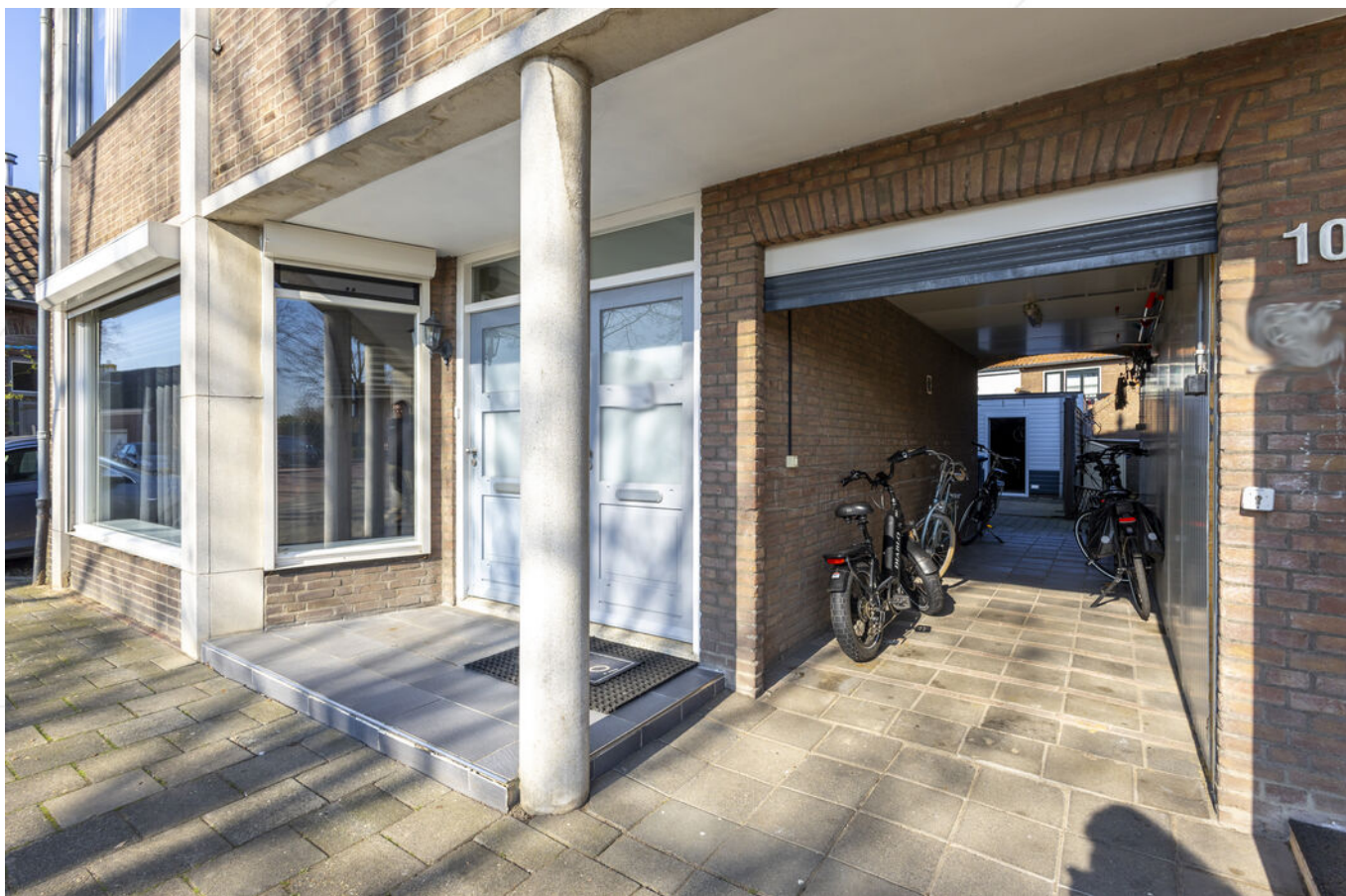
Entree/ toegang tot afgesloten binnenplaats met berging
