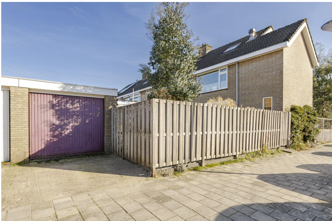
Garage en zijaanzicht woning
