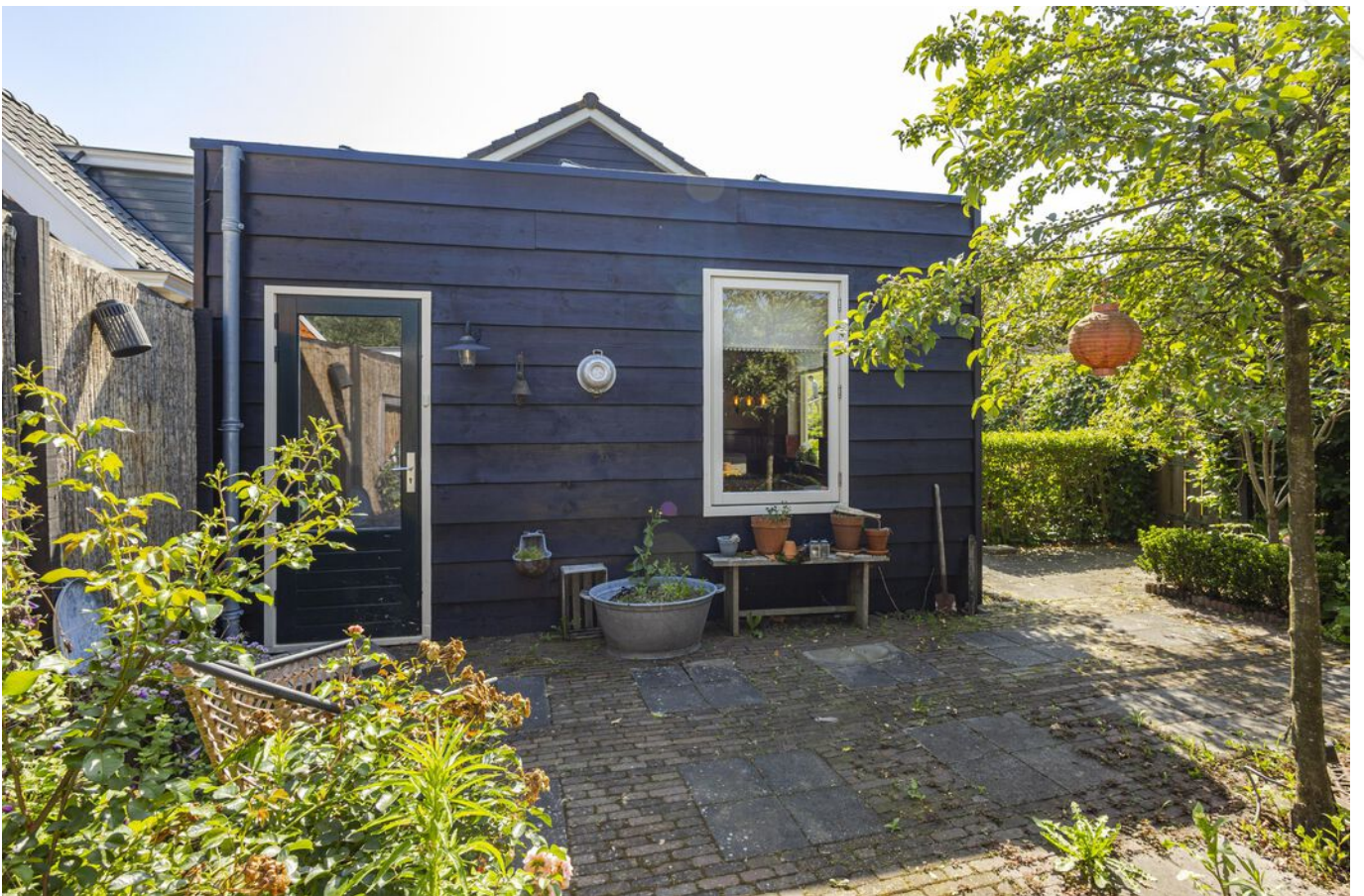
Aanbouw achterzijde woning
