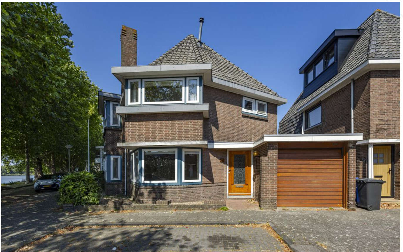
Voorzijde met garage aan de rechterzijde
