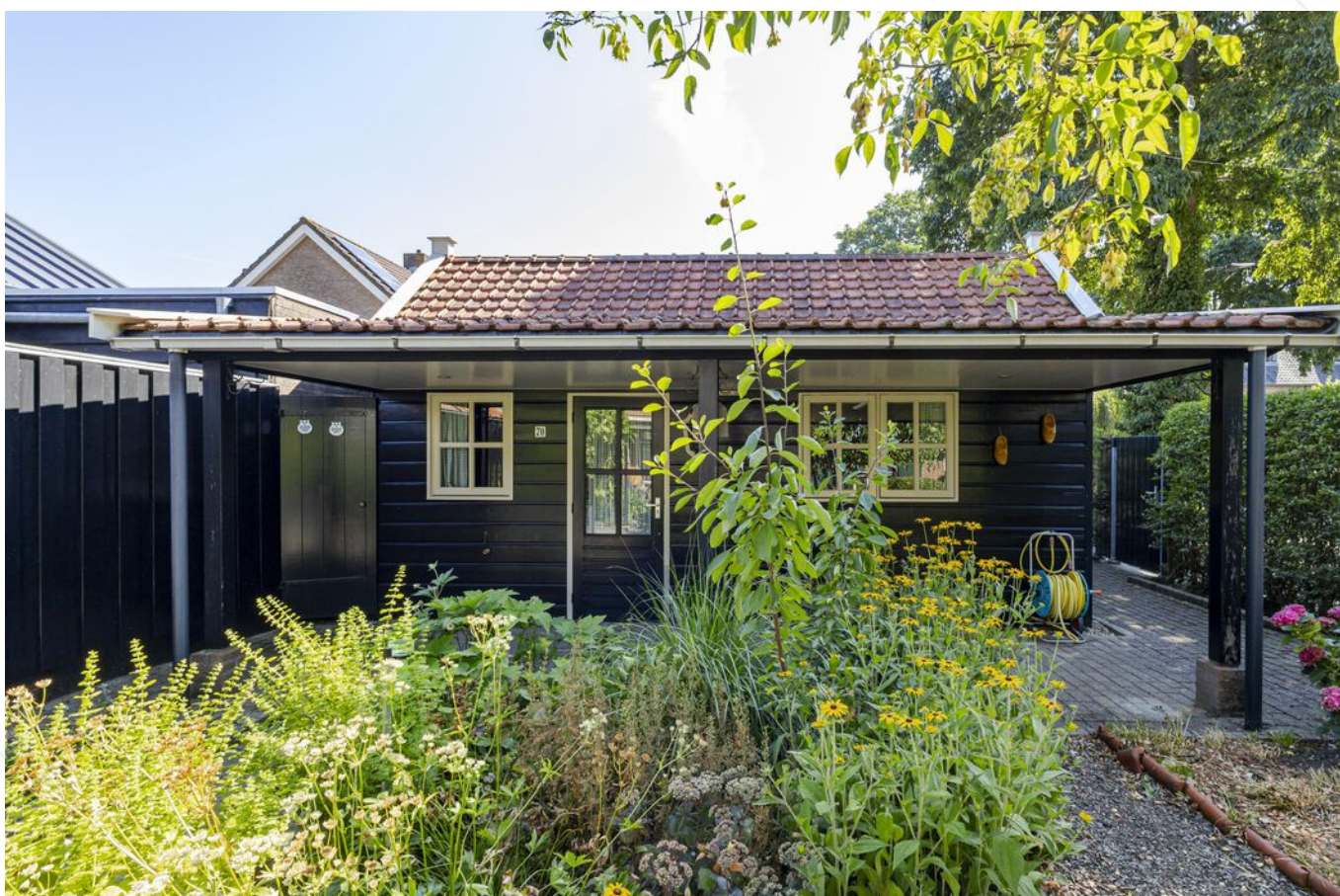
Schuur /garage met overkapping
