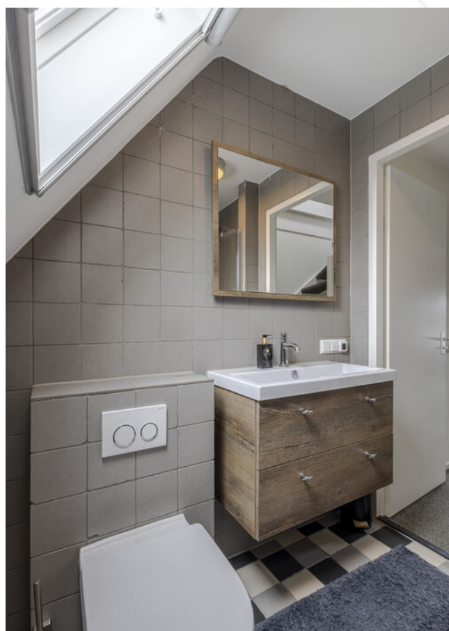
Toilet en wastafelmeubel
