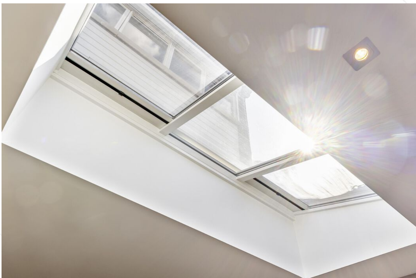
Lichtstraat in de aanbouw
