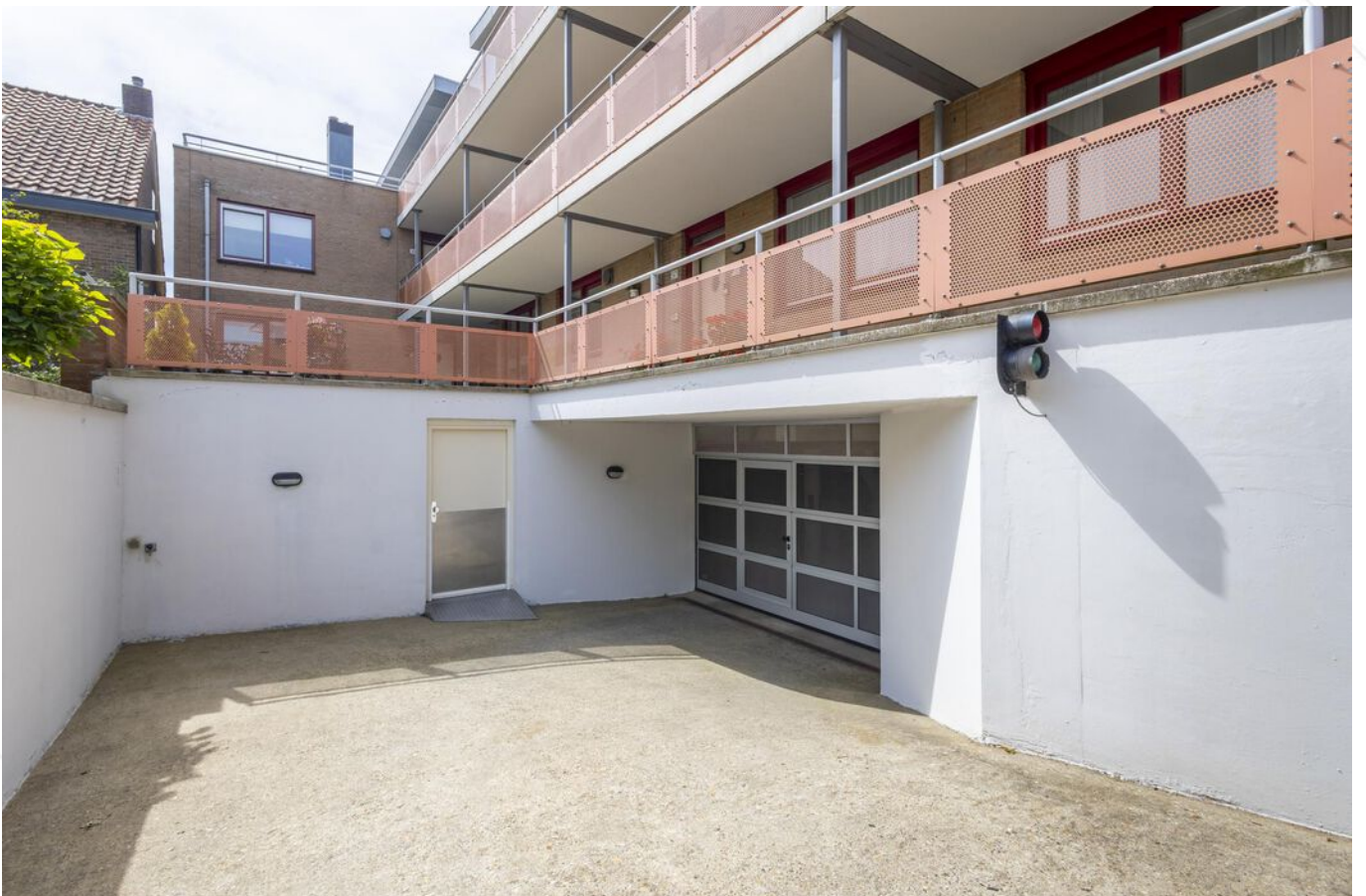
Toegang tot parkeergarage
