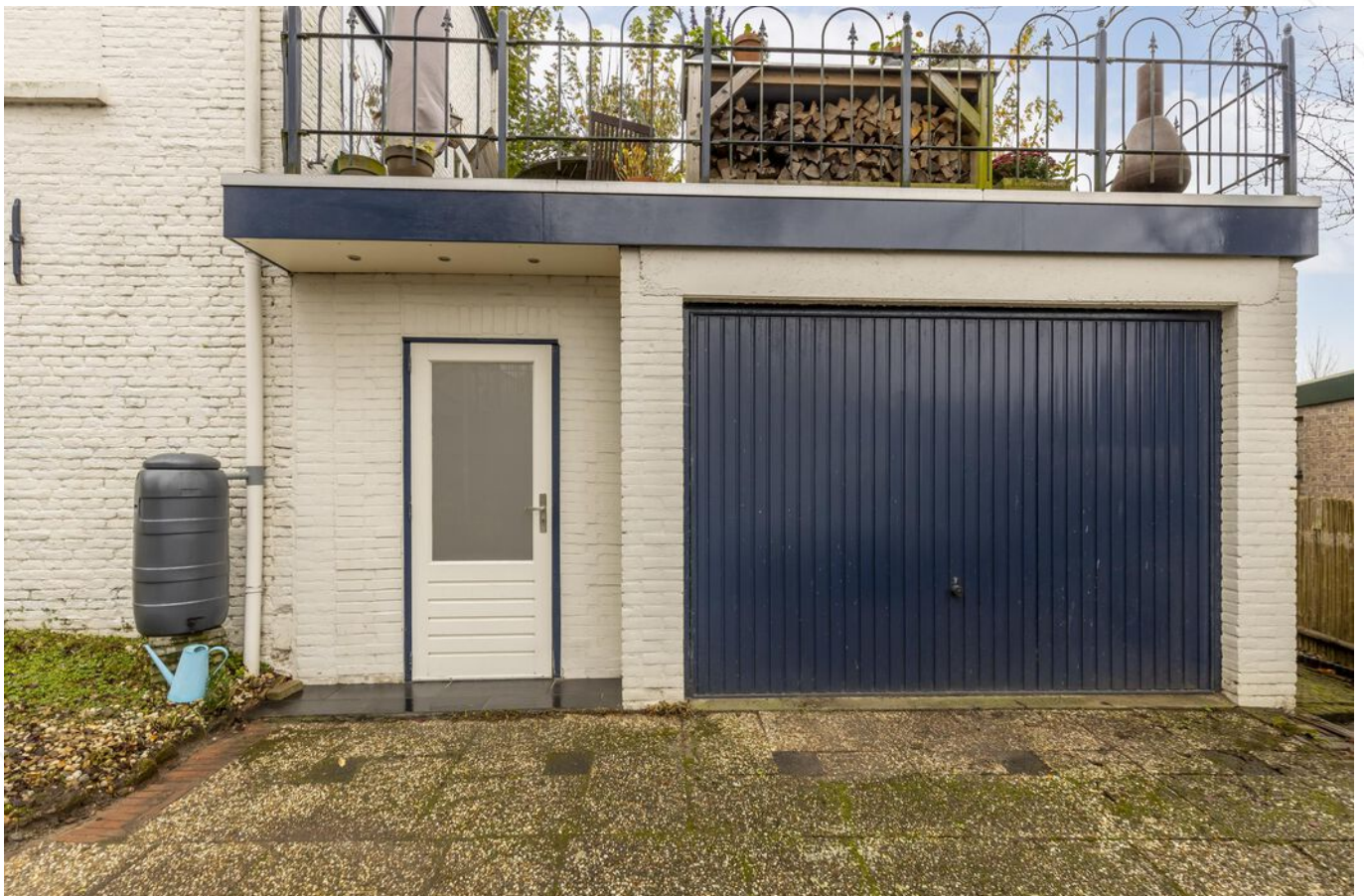
Garage + zij-ingang souterrain
