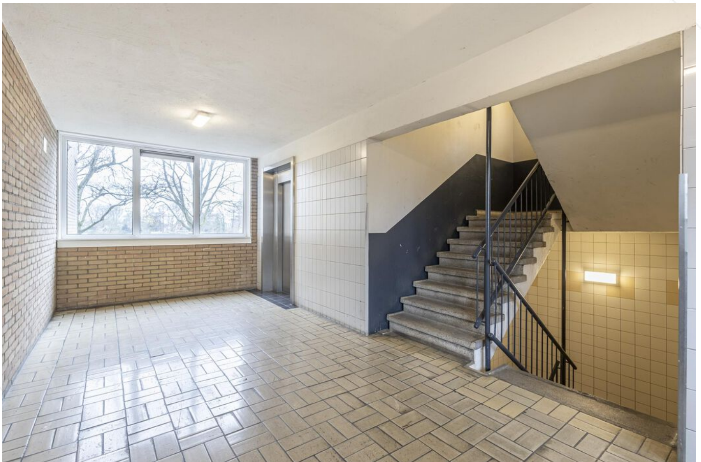
Ttrappenhuis met liftinstallatie
