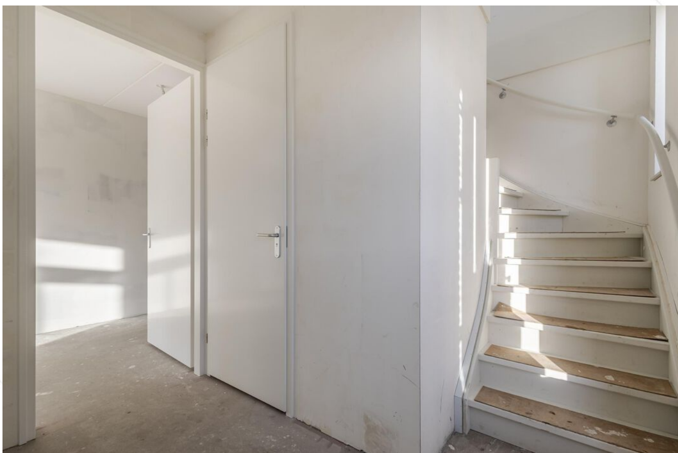
Trapopgang 1e verdieping
