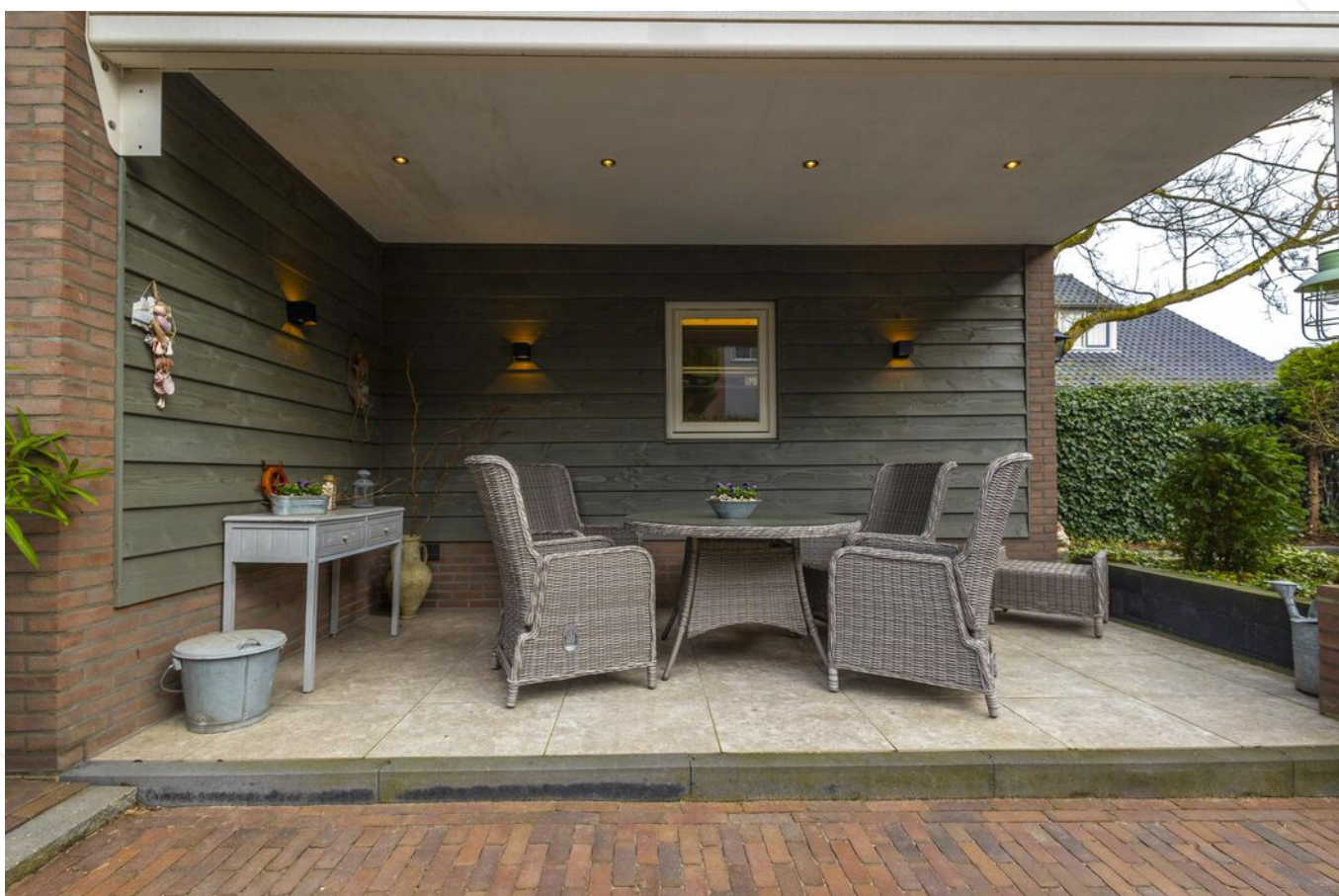
Overkapping op betonnen vloer
