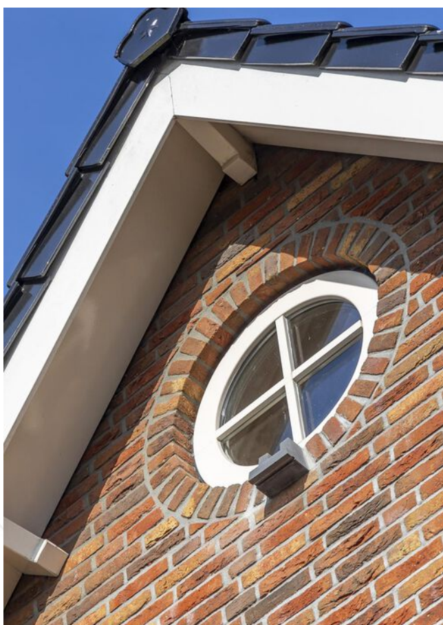
Details in metselwerk
