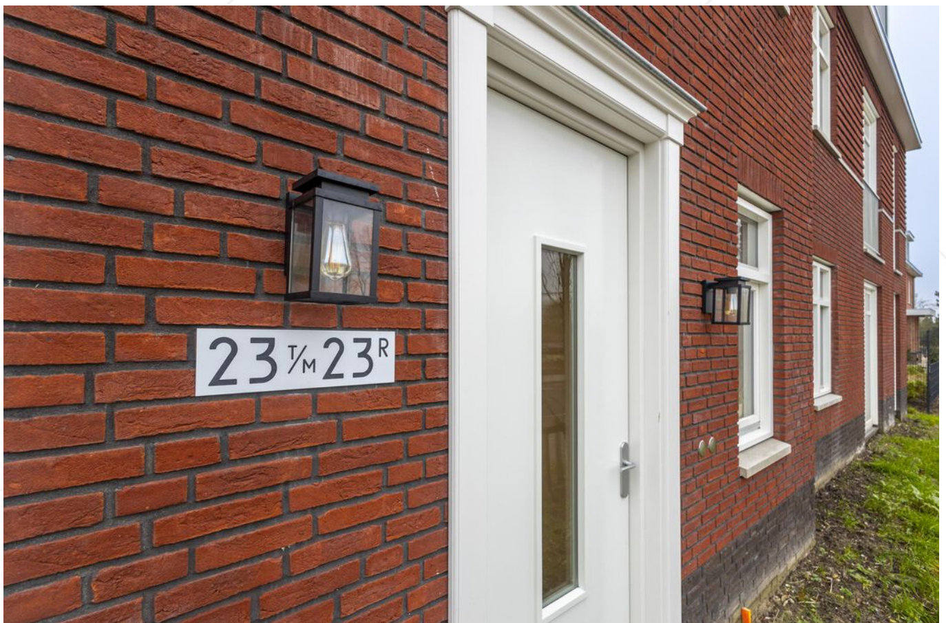
Toegang tot het appartementencomplex
