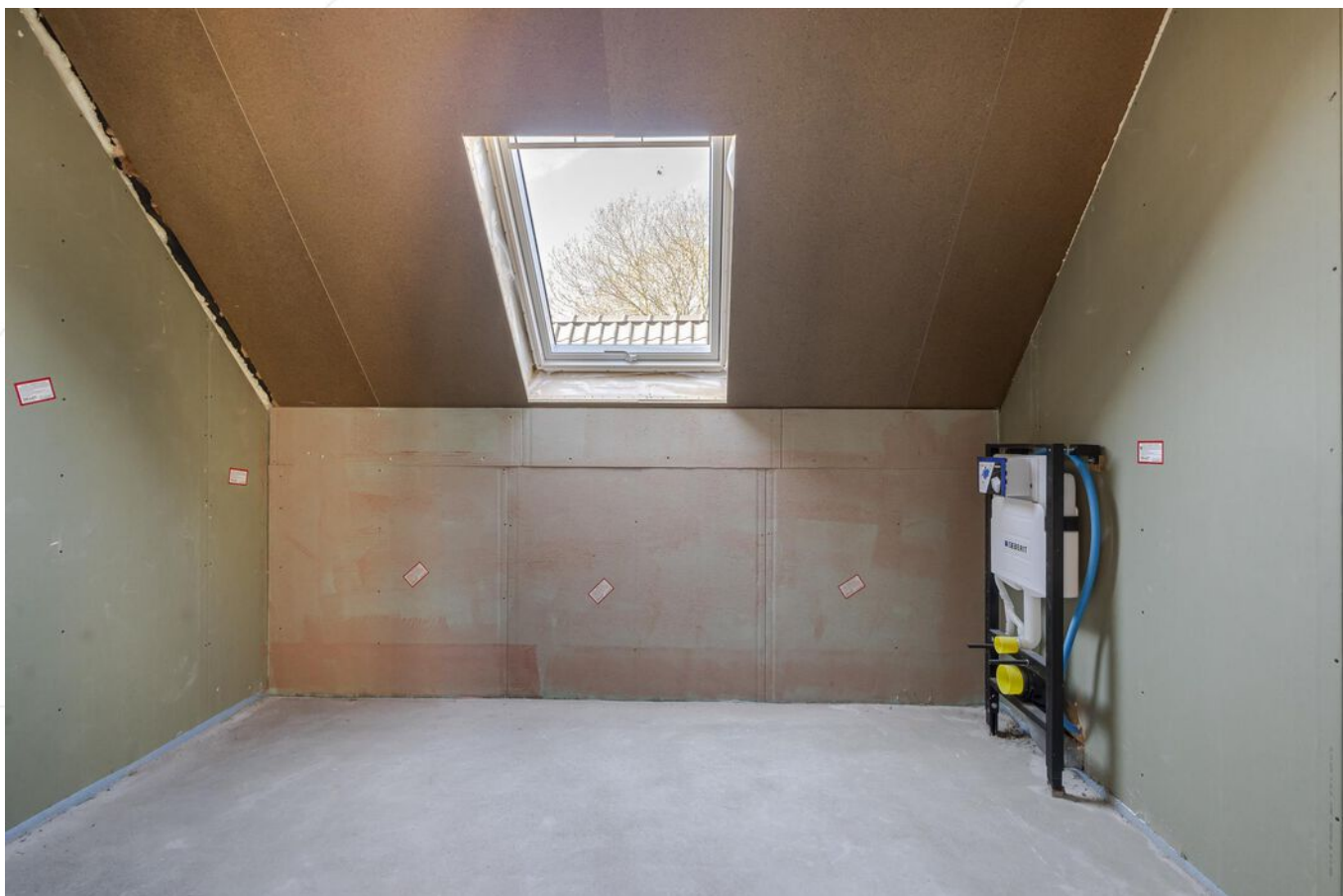
Badkamer 1e verdieping
