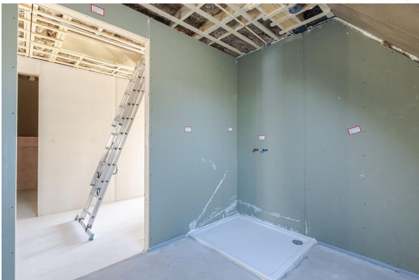
Badkamer 1e verdieping
