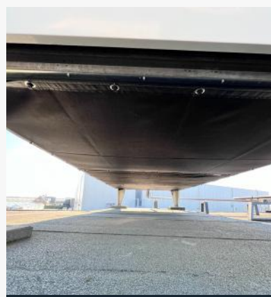
Urządzenia chłodnicze z zamontowanymi ekranami
