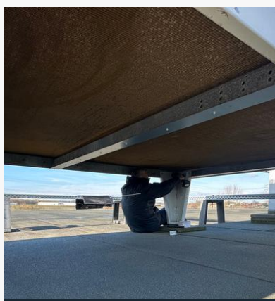
W trakcie instalacji
