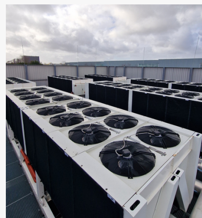
Koelinstallaties voorzien van screens
