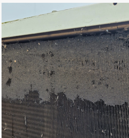
Vervuiling condensors zonder ProScreen
