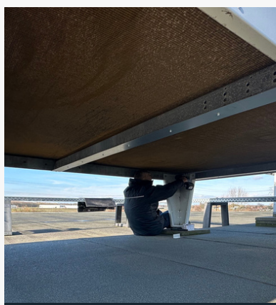
Gedurende de plaatsing
