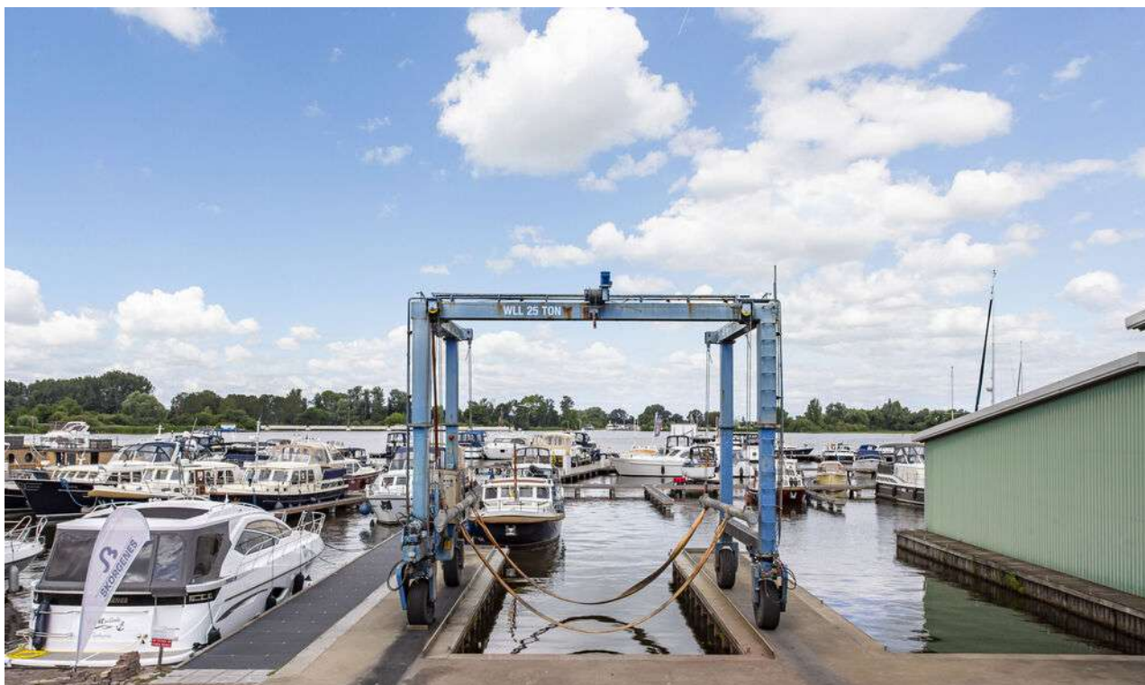
Portaalkraan (cap. 25 ton) met kraangat
