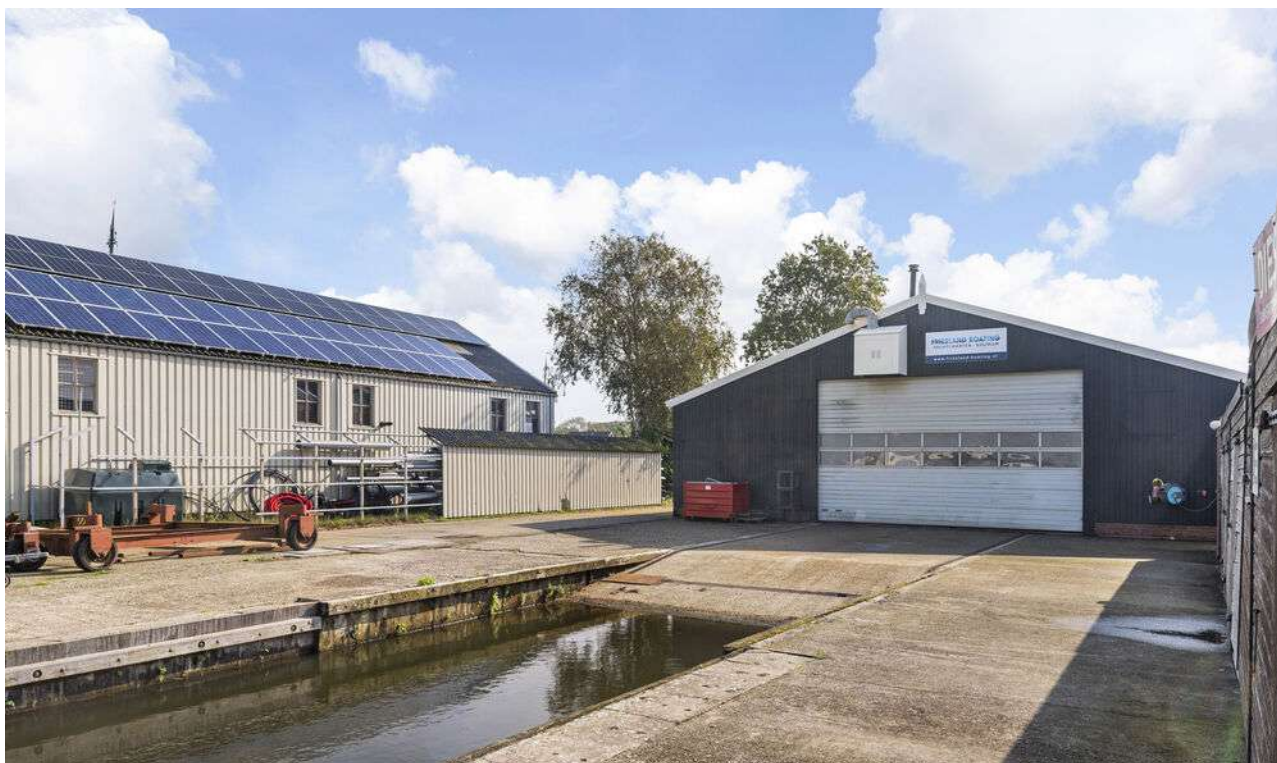
Trailerhelling met afsputplaats
