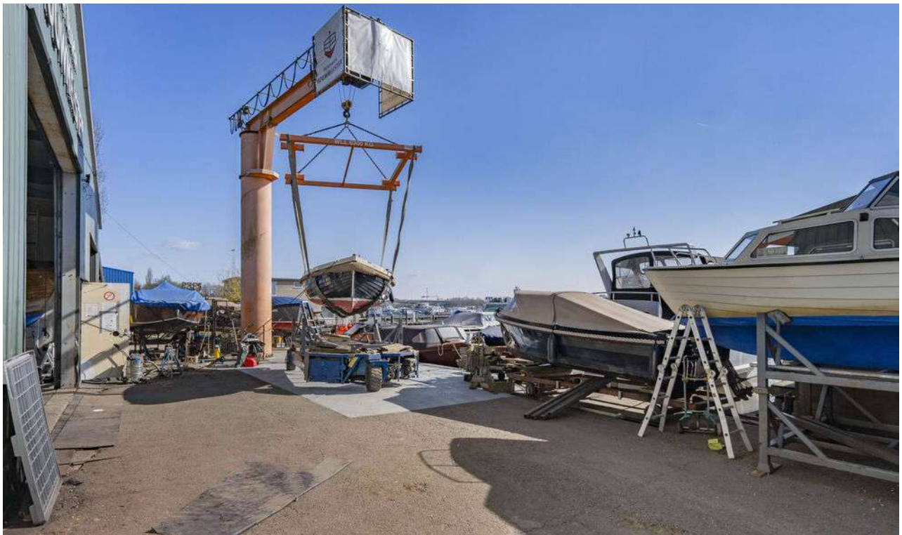
Buitenterrein met kolomkraan
