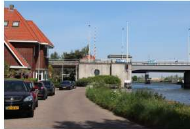
Woningen aan Wilhelminakade. Woningen aan
