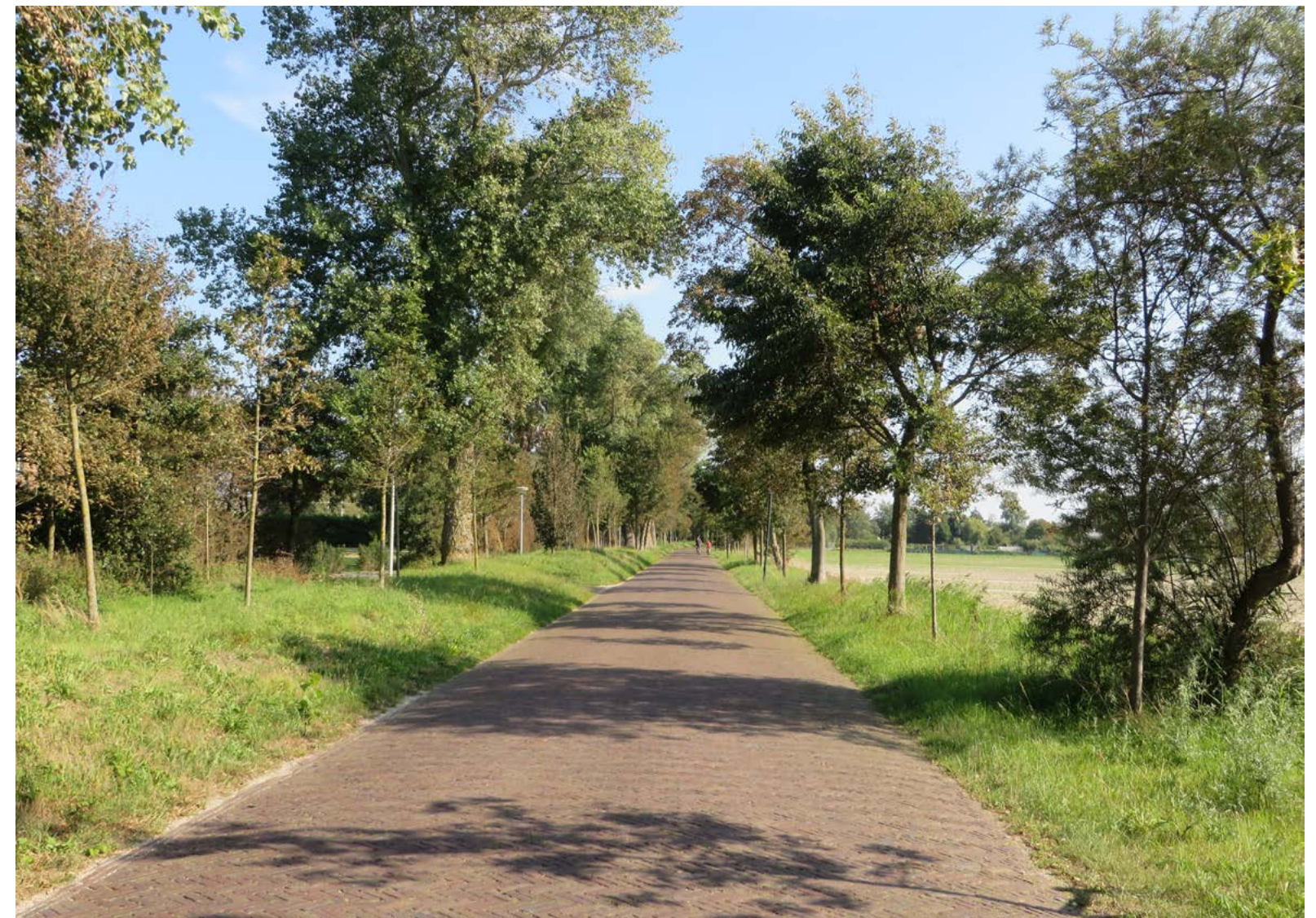
Oude Schulpweg, waalformaat gebakken klinker net als Geversweg en zuidwestelijke deel van Kramersweg.
